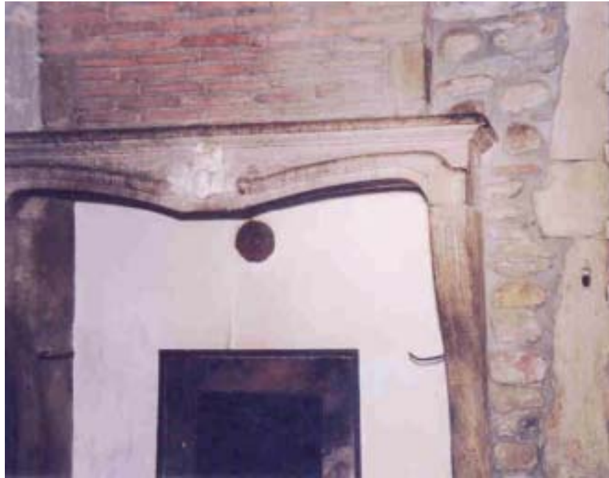
Cheminée restaurée de l'ancien presbytère Collection privée
