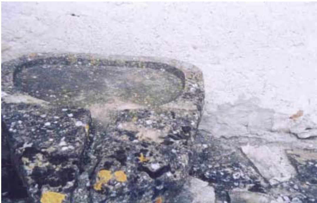
Pierre d'évier de l'ancien presbytère La pierre de molasse traversait entièrement le mur Collection privée
