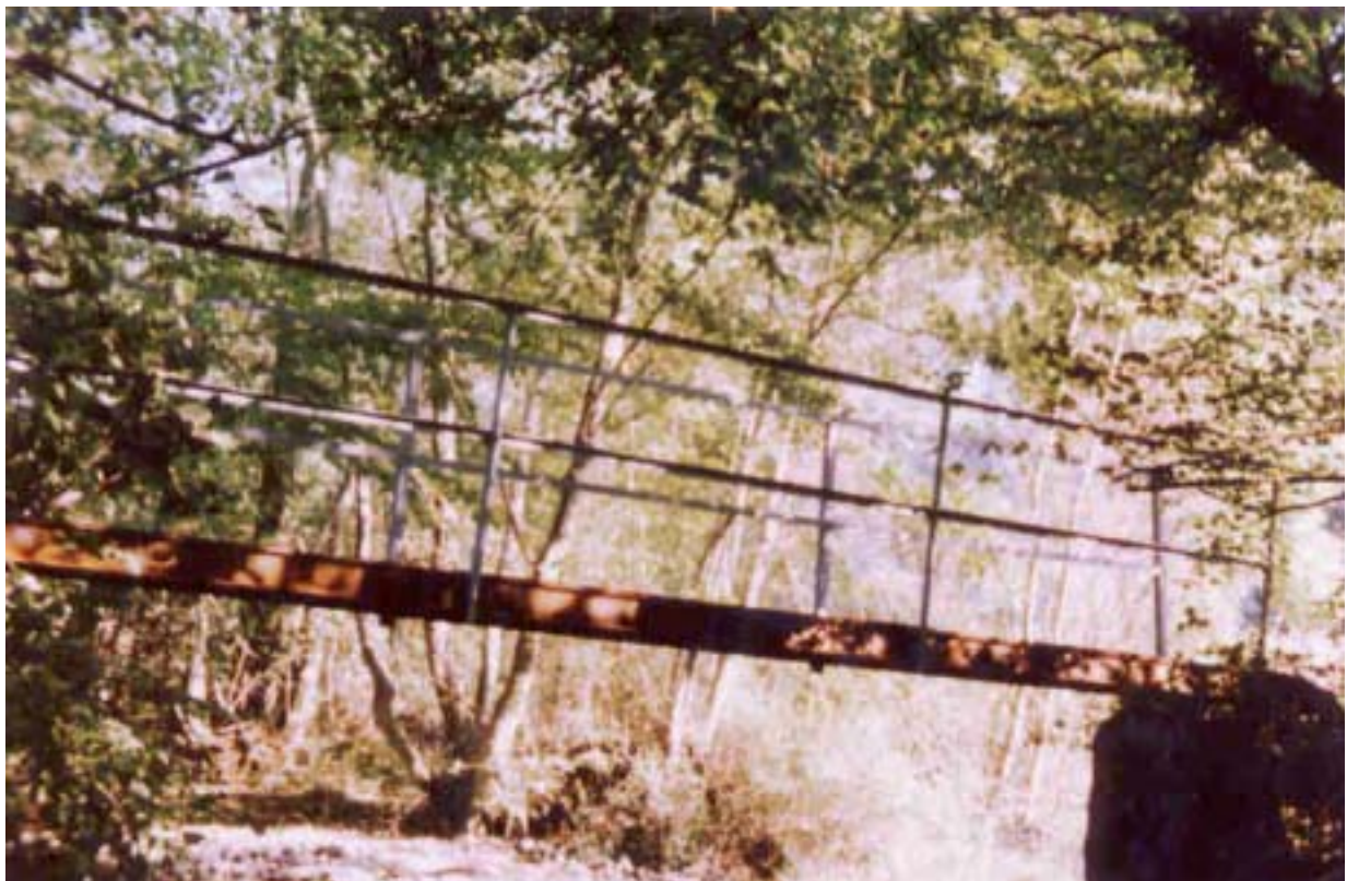
Passerelle sur le Dolon entre Primarette et Revel
